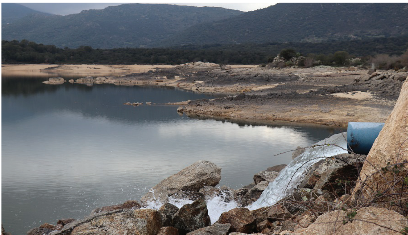
Barrage de e Cotule
