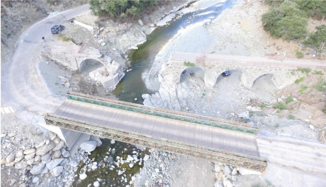
*Vue de l'ouvrage détruit par la crue de 2016 et du pont provisoire au premier plan*
