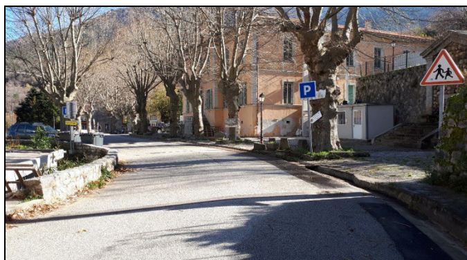
Photo 2 : Début de l'aménagement entrée Sud
