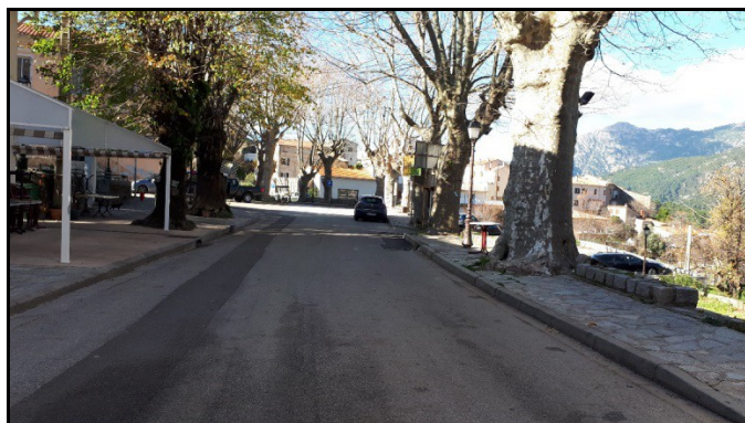
Photo 1 : Début de l'aménagement entrée Nord
