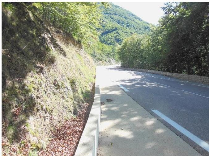
**FIGURE 5 : CUNETTE BETONNEE ACTUELLEMENT EN PLACE**
