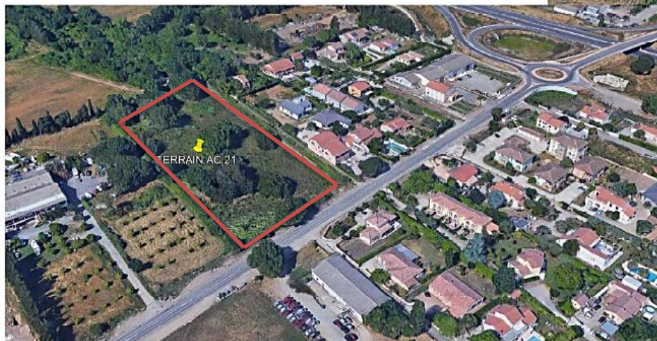
VUE DU SUD OUEST
