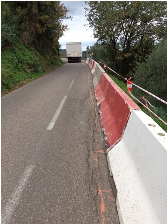
Figure 7 : fissuration vue vers l'Ouest
