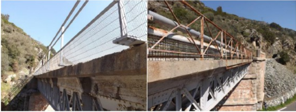
Garde-corps à remplacer (Albano)
