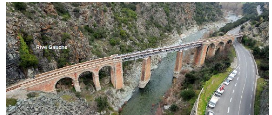
Vue aérienne d'ensemble
