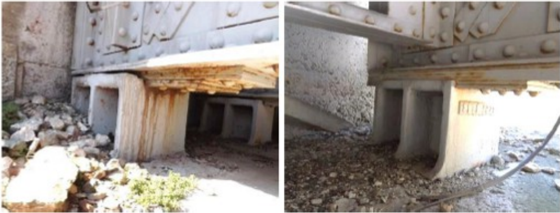
Nettoyage des appuis (Albano)
