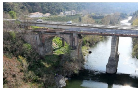
Vue aérienne d'ensemble
