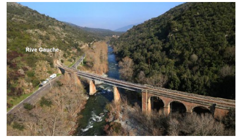
Vue aérienne d'ensemble
