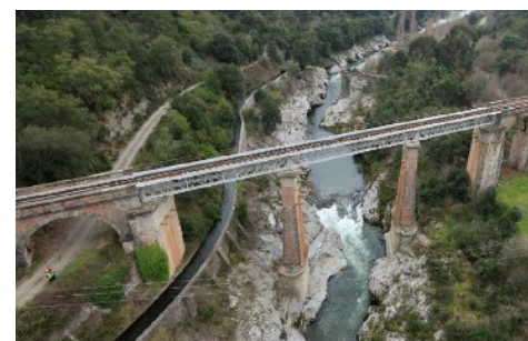
Vue aérienne d'ensemble
