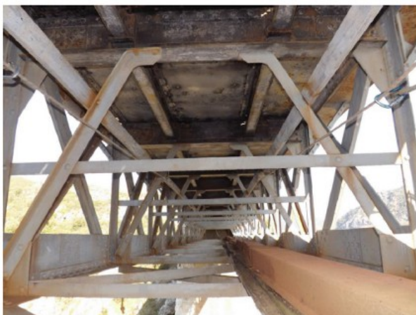
Protection anti-corrosion à prévoir sous tablier (Asco)
