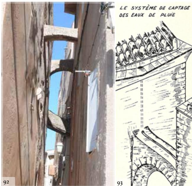
Fig. 92 et 93 : Eau de pluie recueillie à partir du toit circule dans une canalisation contenue dans un mur puis dans un aqueduc.
