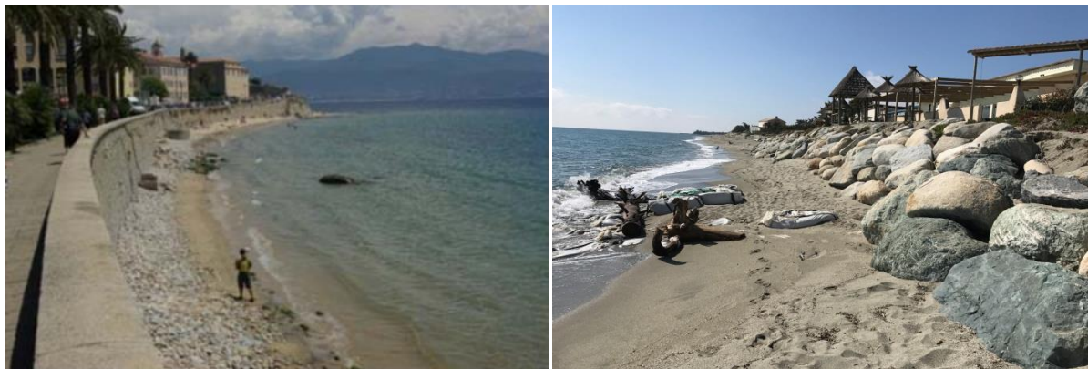
Illustration 16 : Perré maçonné (à gauche ; Aiacciu plage Saint François) et enrochement (à droite ; Moriani)
