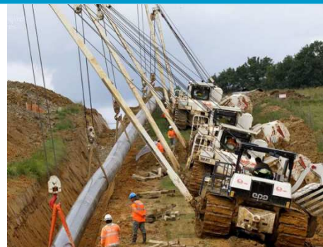
Pose d'un gazoduc et marquage définitif de son tracé
