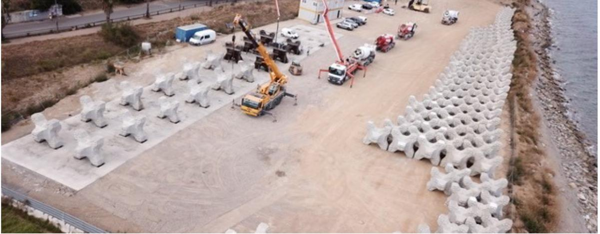
*Arinella, aire de préfabrication des Acropodes II TM pour le futur renforcement des jetées du vieux port de Bastia*
