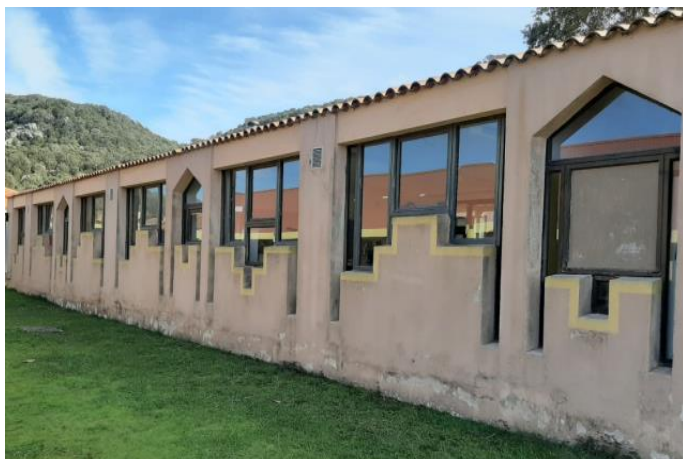
Façade extérieure, menuiseries
