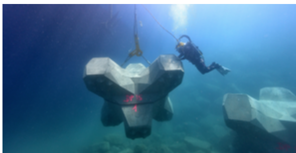
Un bloc Accropode posé par un scaphandrier, Bastia
