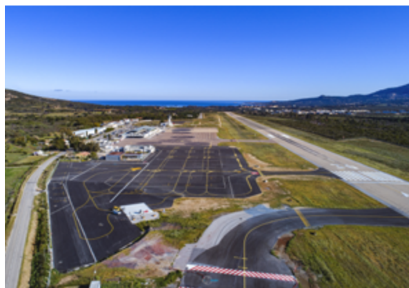
Extension des parkings de l'aéroport de Calvi
