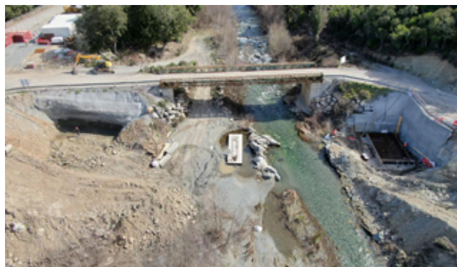
Reconstruction du pont de Casaluna
