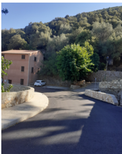
Aménagement de l'ex RD 12
