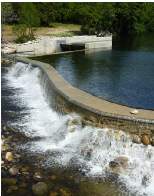
Corse Energia – Mini centrale de type basse chute sur le Taravo à Casalabriva
