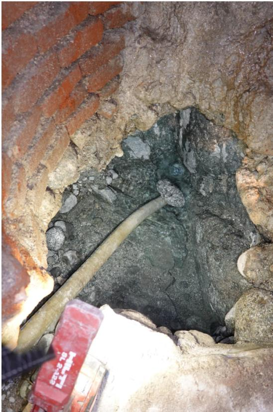
Mise en place d'une structure protectrice externe ancrée sur le socle granitique => analyses indemnes de Légionelles depuis 1 an
