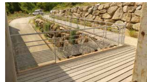
RAMPE D'ACCÈS DESTINÉE AUX PERSONNES À MOBILITÉ RÉDUITE © KEWIN PECHE-QUILICHINI
