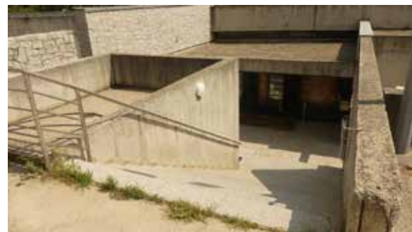
LES ESCALIERS D'ACCÈS ET LE BASSIN SUPÉRIEUR © KEWIN PECHE-QUILICHINI
