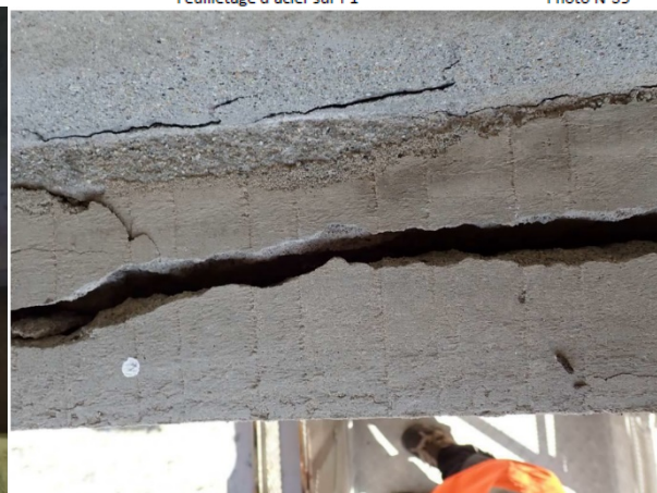
Épaufrure sur P4 – vue de dessus
