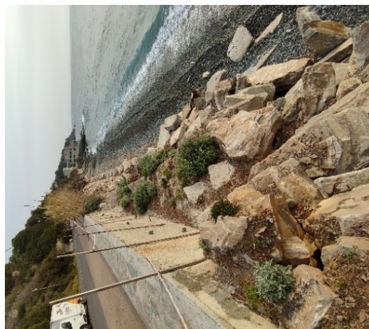
Paroi clouée provisoire en partie Sud - 2020
