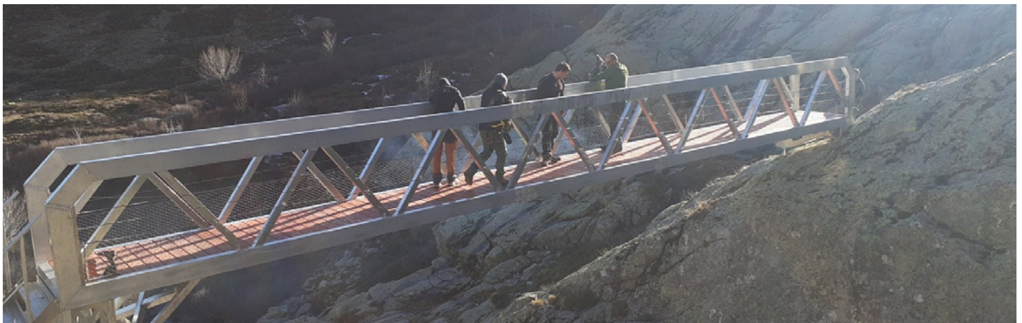
Passerelle de Lozzi
