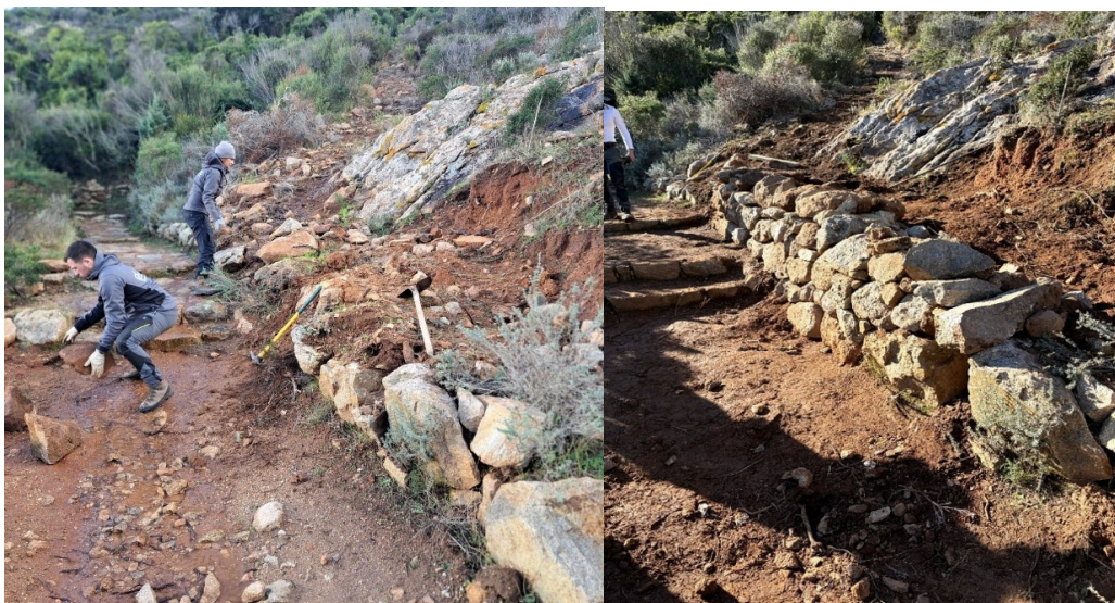
Réfection de mur en pierres sèches
