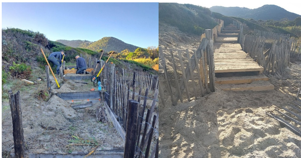
Réfection de platelage bois
