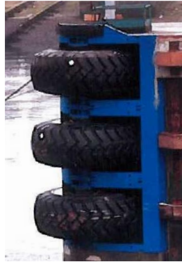
Figure 6. exemple de défense de coin de quai à rouleaux (fabricant Trelleborg)
