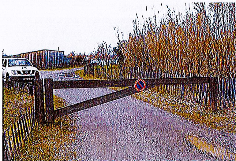
Figure 4 : piste de service et barrière en bois garantissant un accès réservé.
