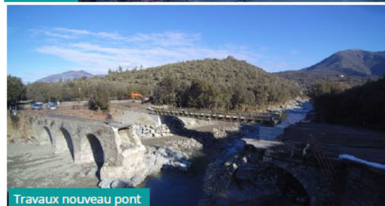
Travaux nouveau pont
