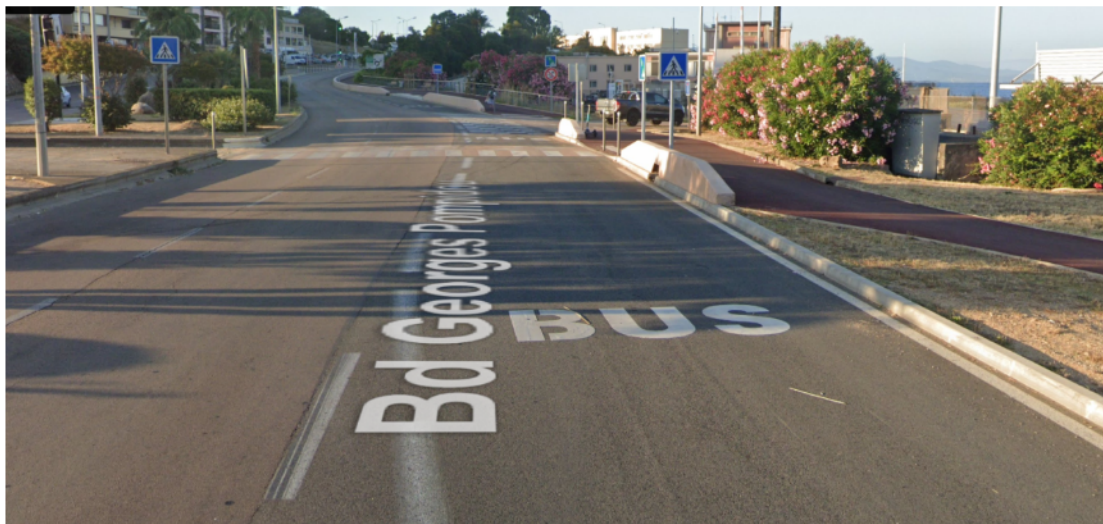
Voie bus et point d'arrêt bus existant au niveau d'Asprettu
