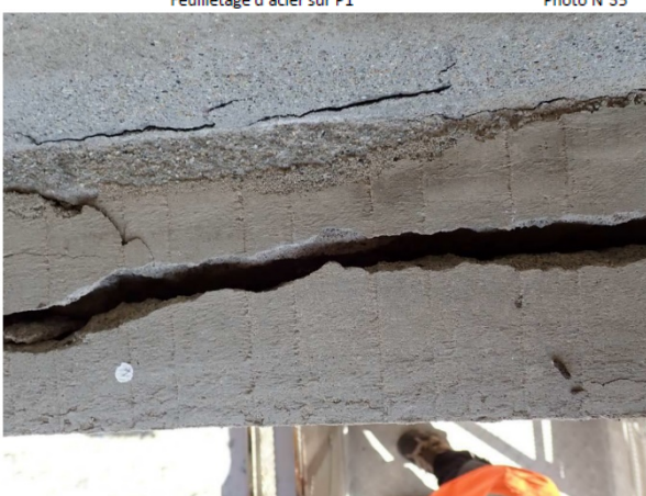
Épaufrure sur P4 – vue de dessus
