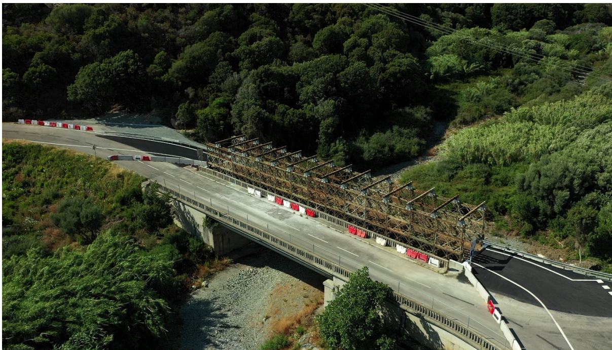
Pont d'Albu et pont provisoire
