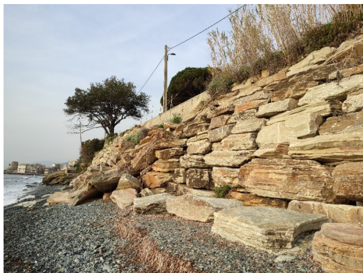
Photographie du site (partie sud)
