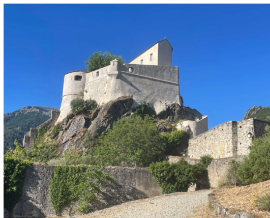
Vue après travaux (septembre 2025)
