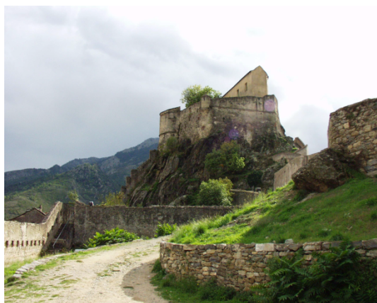
Vue avant travaux
