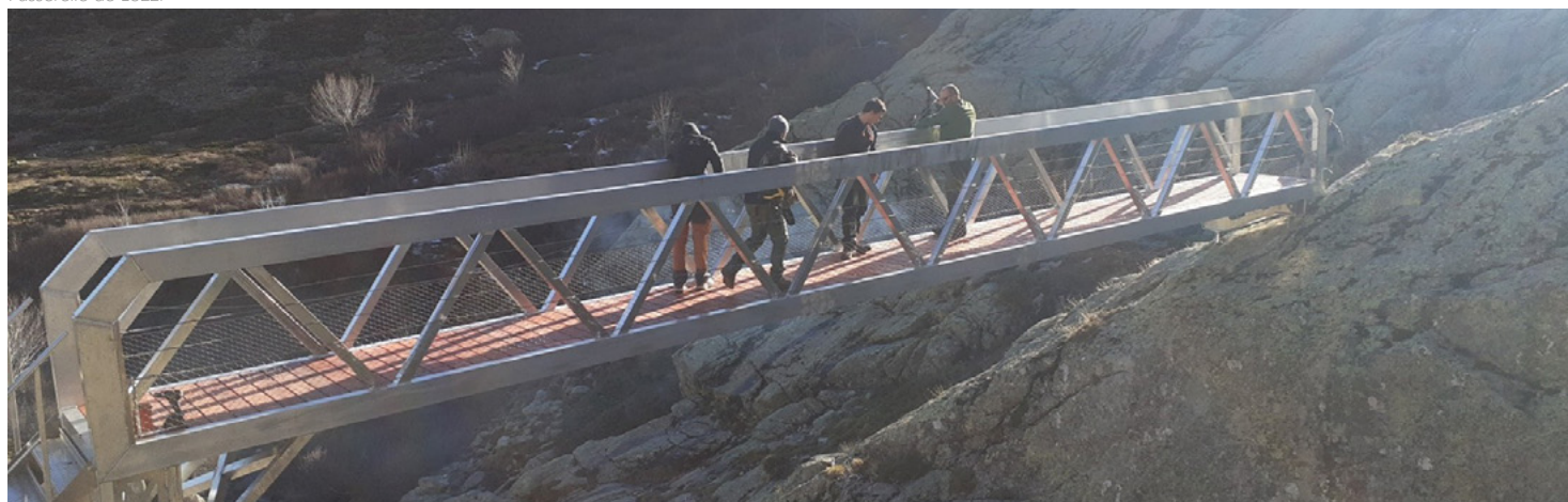
Passerelle de Lozzi
