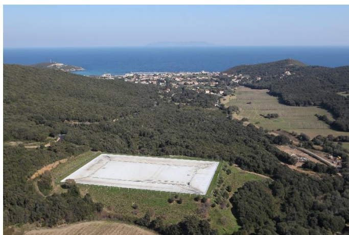
Figure 162 : Réserve de grande capacité Stullone (Ruglianu)
