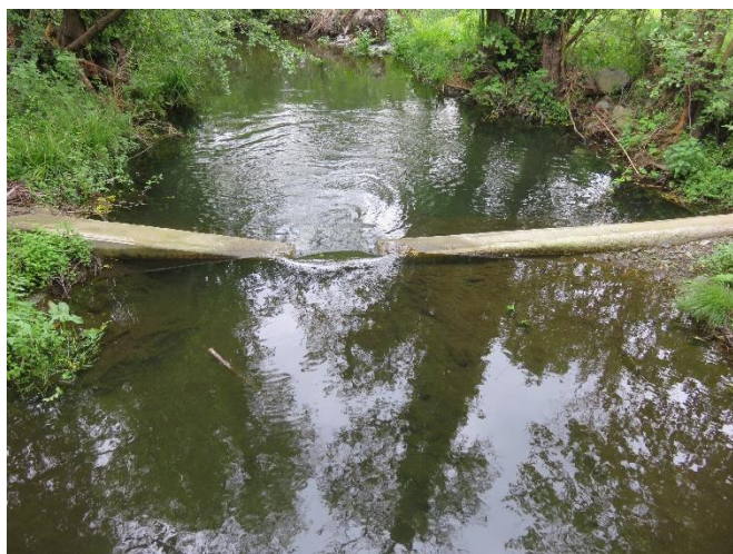
Figure 169 : Seuil de la station hydrométrique du Luri
