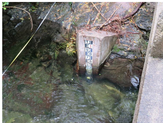
Figure 170 : Echelle de la station hydrométrique du Luri
