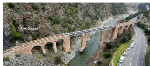
Vue aérienne d'ensemble
