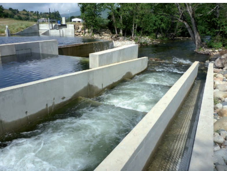
Passé à poissons et anguilles de la microcentrale hydro-électrique de Calzola
