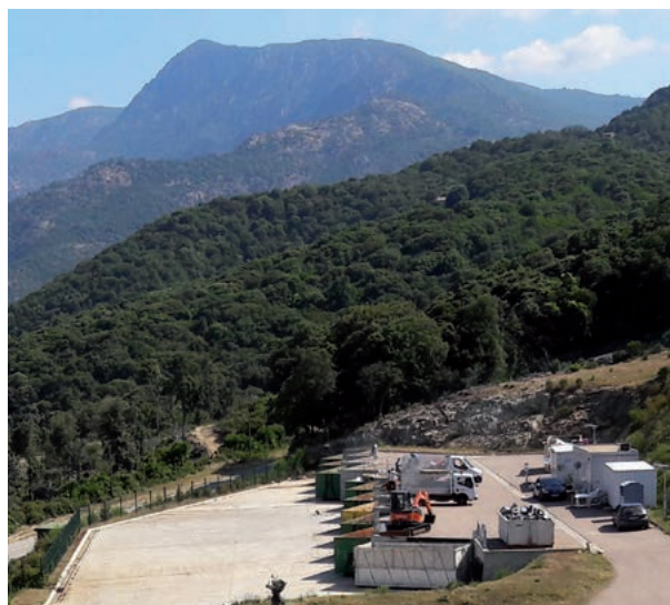
Déchetterie de Vico
