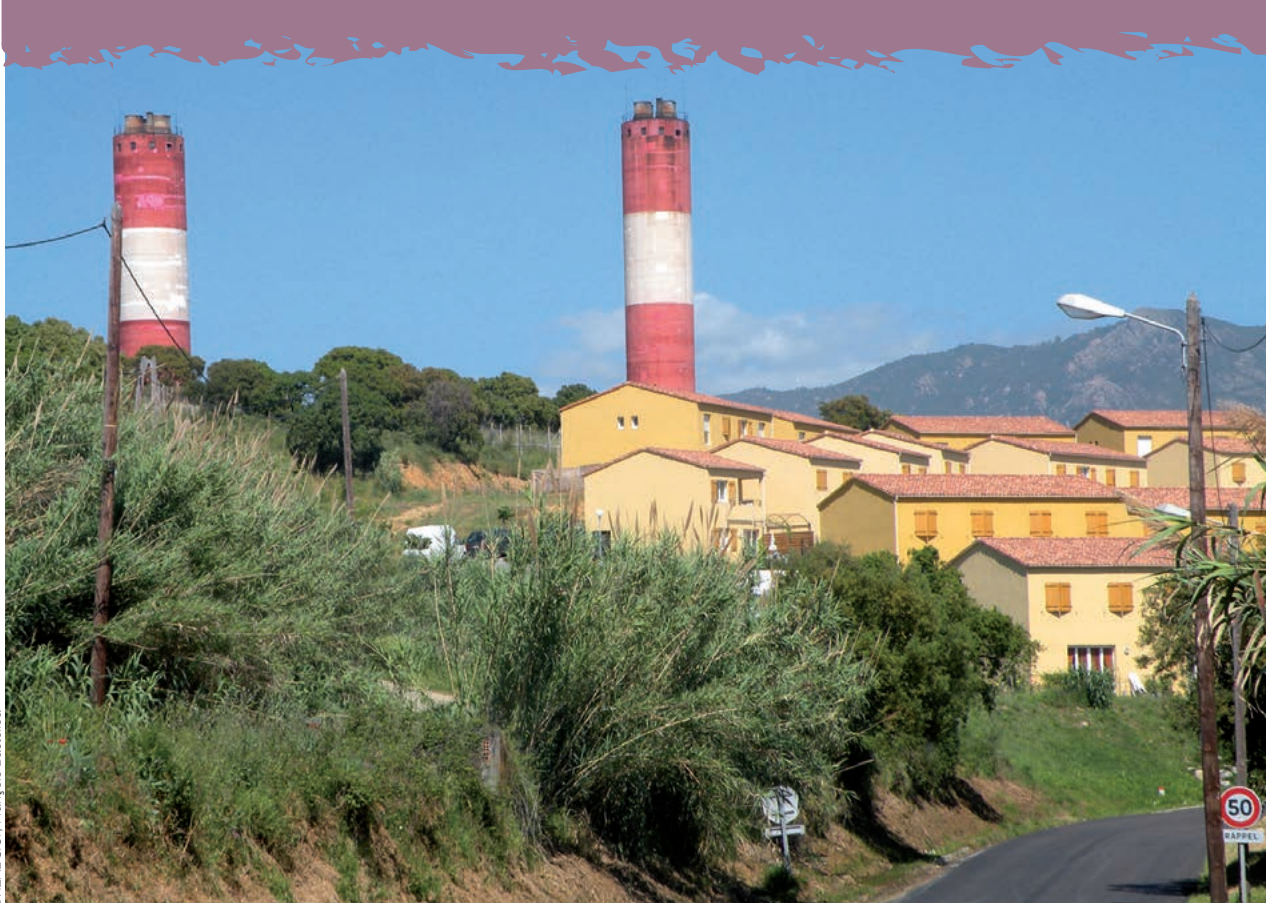
Centrale thermique du Vazzio, Ajaccio
