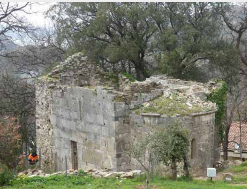
Vue générale de l'église San Petru à Barbaggio © Patrick Ferreira, Inrap
