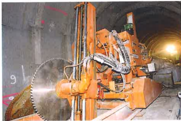
Tunnel de PONTE ROTTO - Béton projeté - Matériel de prédécoupage de la maçonnerie
